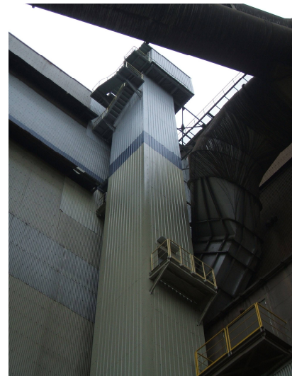
S 社 大分 殿 製鋼 RH エレベーター 人荷用 4 名 300Kg 6stop 2010/02 機械室有り
